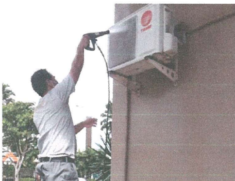
รูปภาพที่ 2.31 การทำความสะอาดระบบปรับอากาศ
