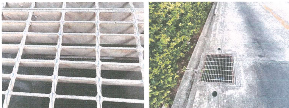
รูปภาพที่ 2.42 ตะแกรงดักมูลฝอย
