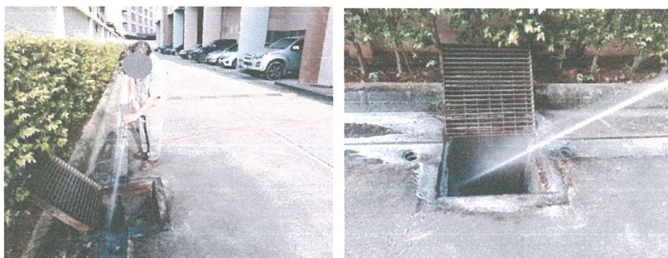
รูปภาพที่ 2.66 การขุดลอกท่อและวางระบายน้ำ
