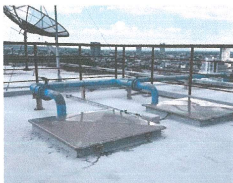
รูปภาพที่ 2.33 ถังเก็บน้ำสำรอง
