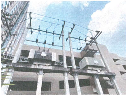
รูปภาพที่ 2.24 หม้อแปลงไฟฟ้า
