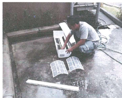
รูปภาพที่ 2.31 การทำความสะอาดระบบปรับอากาศ
