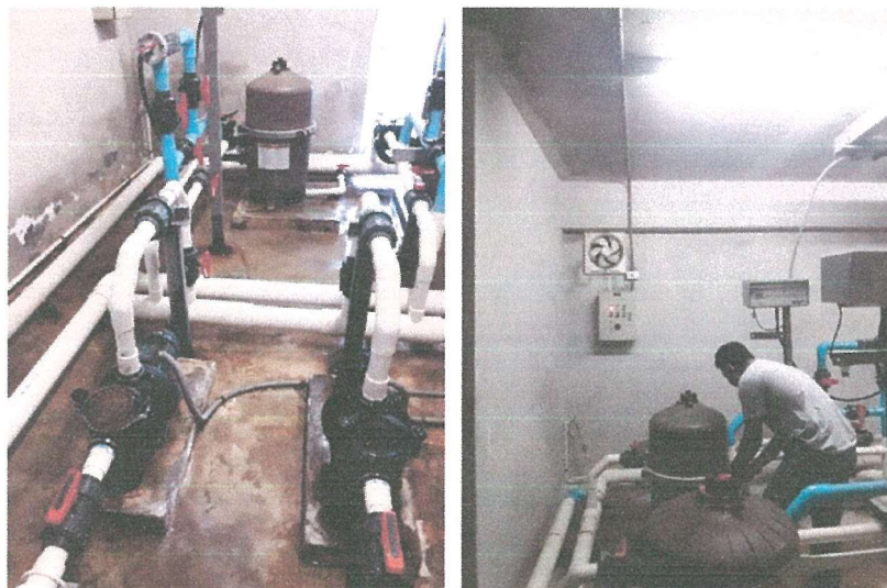
รูปภาพที่ 2.2 การตรวจสอบรอยรั่วของท่อประปา
